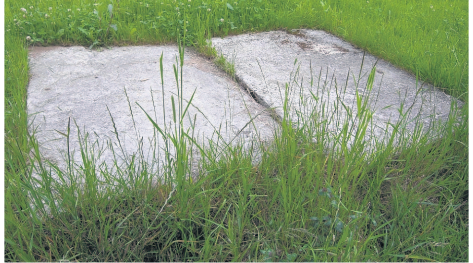
Damit niemand in den Schacht fällt, ist dieser mit schweren Betonplatten gedeckt.
