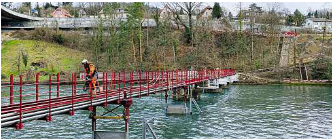
Die tonnenschweren Elemente des Limmatstegs werden montiert
